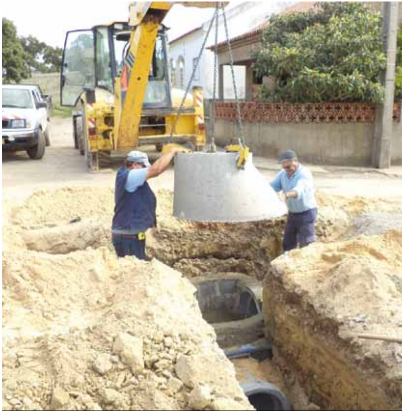
Execução da rede de águas pluviais no Outeiro do Lobo.
