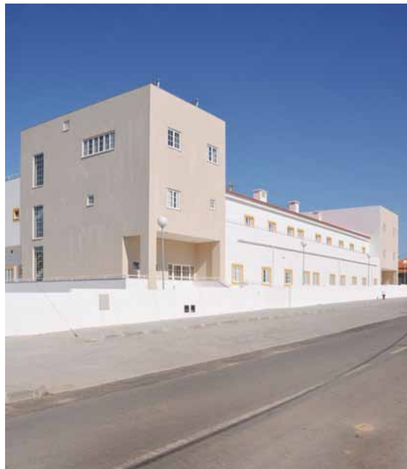
Estrutura Residencial para Pessoas Idosas na Abela , construída no âmbito do programa PARES, com financiamento também da Câmara Municipal de Santiago do Cacém; num investimento de cerca de 2 milhões de euros.
