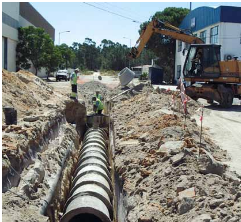
Reformulação da rede de esgotos domésticos e de águas pluviais, bem como os trabalhos de prolongamento da rede de abastecimento de águas na Rua dos Electricistas.
