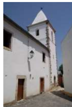
Beco da Misericórdia, onde se vêem duas das três portas, anteriores ao terramoto, que serviam as Casas da Câmara e a Cadeia, assim como a Torre do Relógio (fotografia: José Matias, 2007, CMSC).
