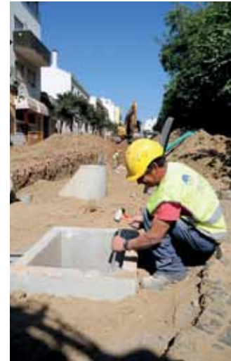
Rua Egas Moniz tem nova rede de esgotos
