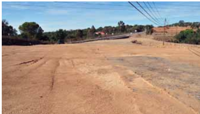
Terraplanagens e caminhos rurais que são perigo rodoviário enorme.
