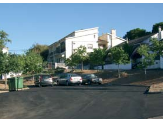
Santiago do Cacém / Bairro da Formiga também sofreu profundas obras de melhoramentos
