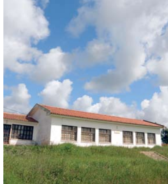
Câmara cede ao Estado edifício de antiga escola para futuro quartel da GNR do Cercal do Alentejo
