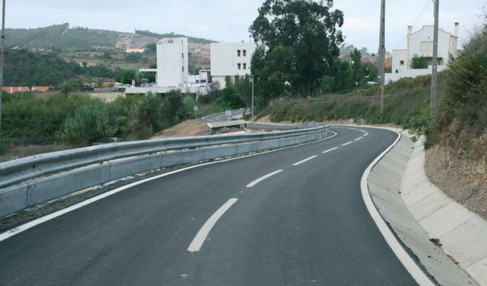
Cercal / Foi estabelecida a ligação rodoviária entre a rua Dr. Beja da Costa e a rua Dr. Álvaro Cunhal. A profunda intervenção da Câmara Municipal visou requalificar a freguesia e incluiu movimento de terras, sub-base, base, pavimentação, muro de suporte, guardas de protecção, sinalização e rede de drenagem de pluviais
