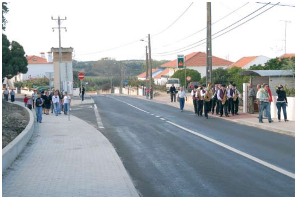
Brescos / A obra da estrada de Brescos consistiu na execução da rede de drenagem de pluviais, passeios, pavimentação, arranjos exteriores e sinalização, no valor de 259.475,64 euros
