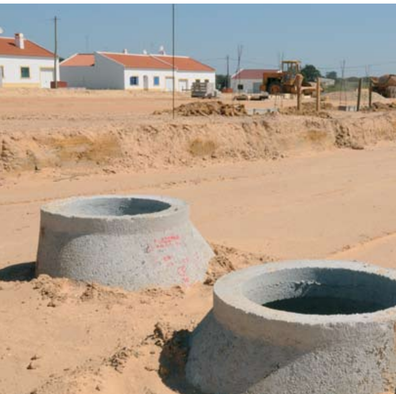
Ermidas-Sado / O Loteamento da Carrusca foi alvo da execução de pluviais por parte da autarquia, melhorando as condições de vida
