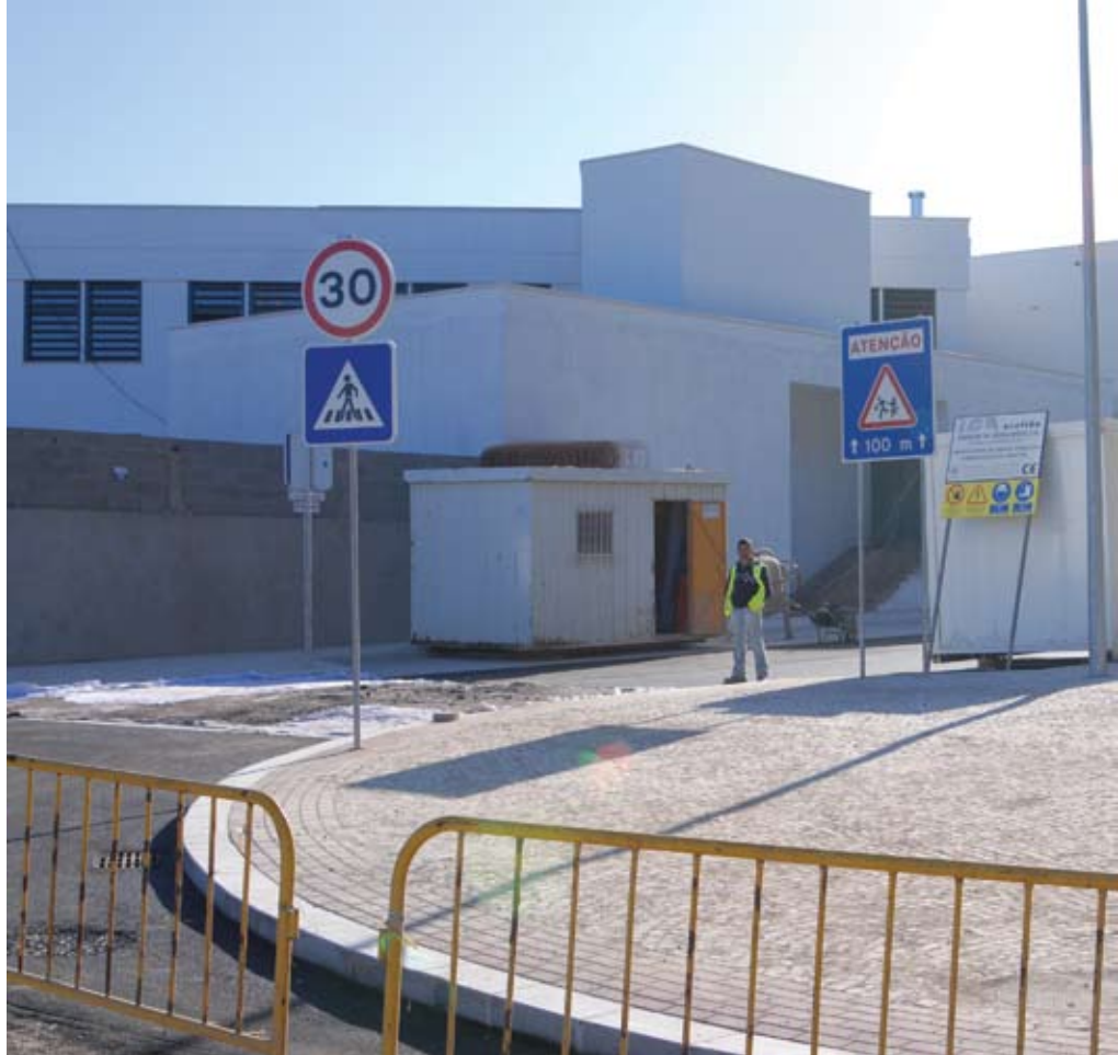
Santiago do Cacém / A nova Escola Básica Integrada está a ser construída num terreno cedido gratuitamente pela autarquia. A obra é comparticipada em 10% pela Câmara Municipal, que ainda executa os arranjos exteriores
