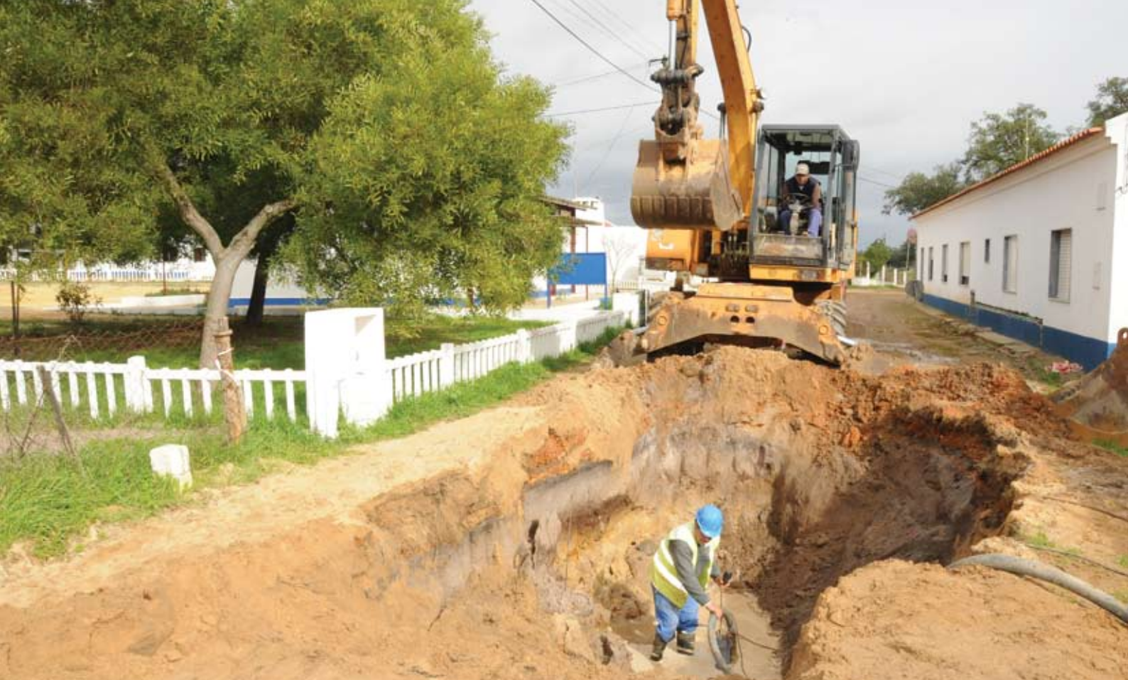
São Domingos / A Câmara Municipal está a executar esgotos domésticos e pluviais em Foros do Locário, que inclui abertura de vala, colocação de tubos e construção de caixas de visita, imprescindíveis nesta localidade. Na freguesia não existia rede de drenagem de águas e a obra é feita por administração directa da autarquia
