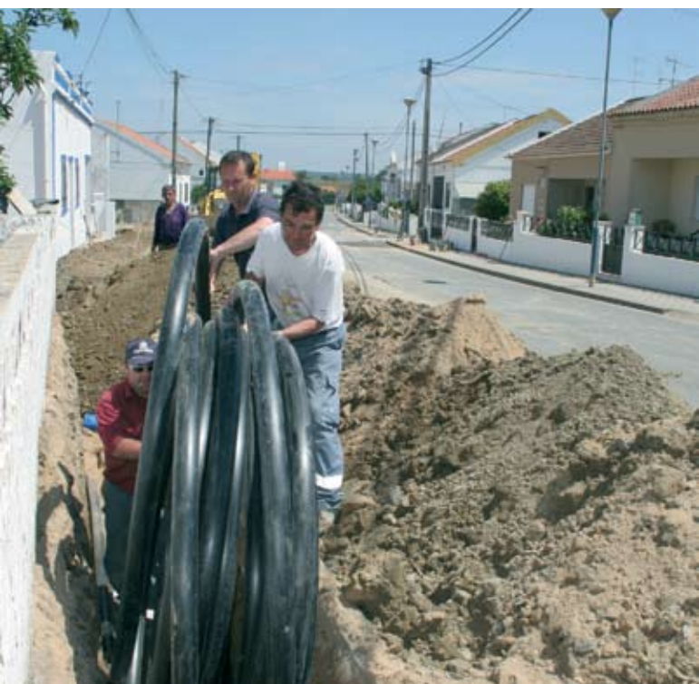
São Bartolomeu da Serra / Construimos o sistema de abastecimento de água à localidade de Outeiro da Moita que se situa numa zona elevada
