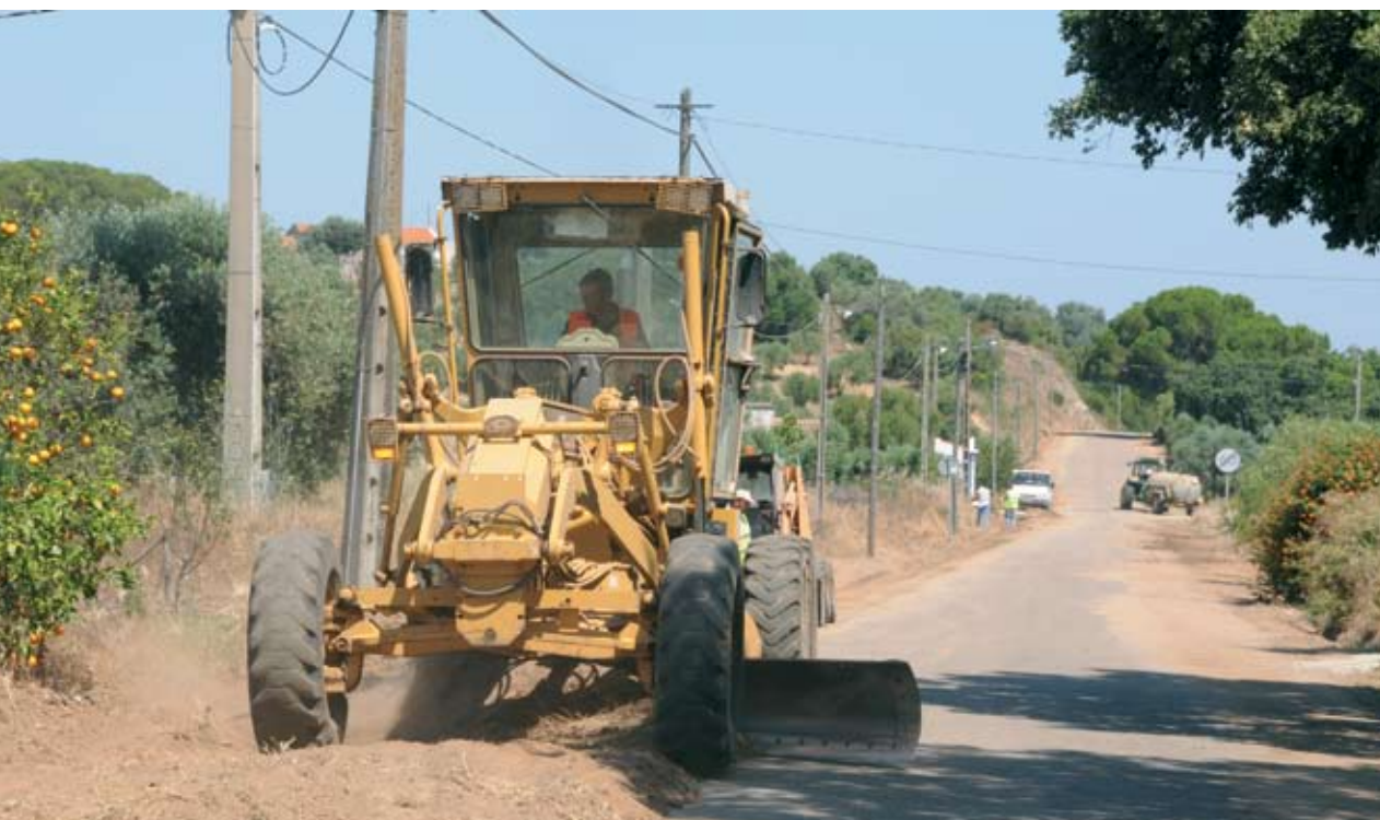
Santa Cruz / Melhorámos os acessos dos caminhos rurais da freguesia com o corte de arbustos na Estrada Municipal 548, a limpeza de bermas, a abertura de valetas e o nivelamento do pavimento, trabalhos executados com meios próprios da autarquia
