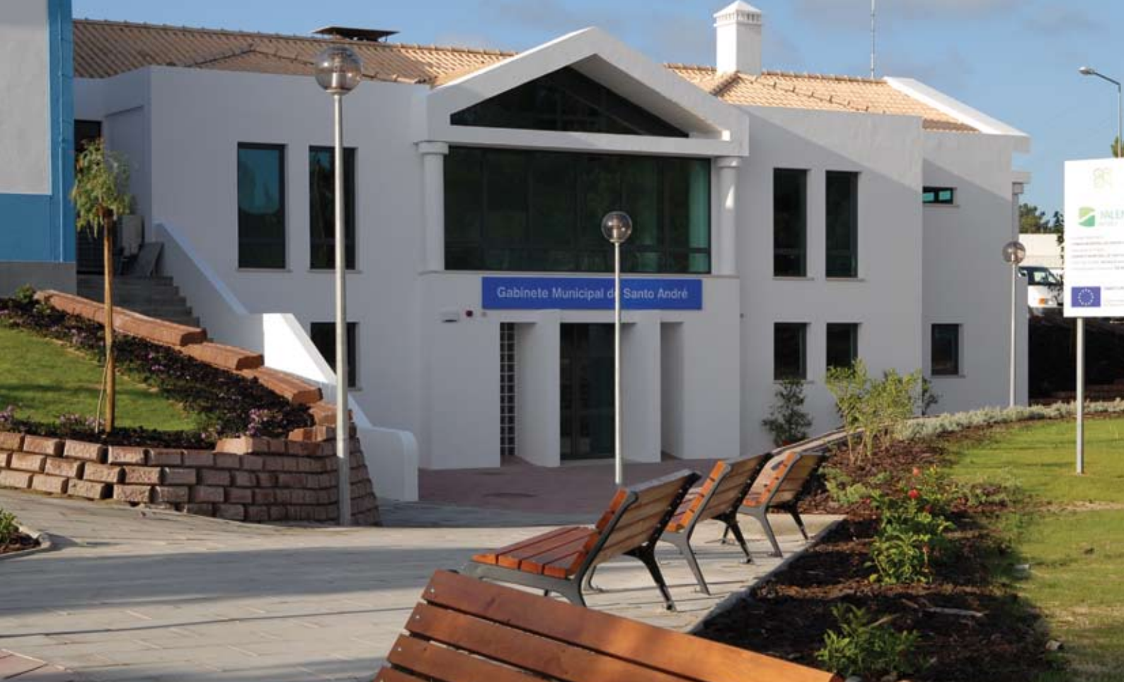
Santo André / O Gabinete Municipal é uma das principais obras do mandato. Inaugurado no dia 4 de Julho de 2009, foi construído a pensar na população de Santo André que para tratar de assuntos autárquicos tinha que se deslocar a Santiago do Cacém
