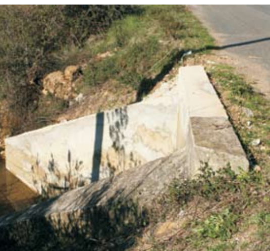
Vale de Água / Melhoramentos dos muros de ala na EM 533 em Vale das Éguas e Vale Seco
