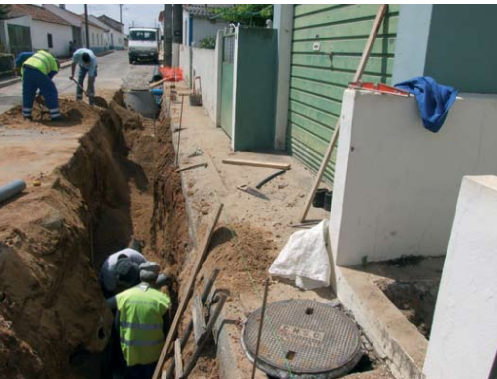
Abela / A Câmara Municipal procedeu à execução da rede pluvial no Arealão. Por meios próprios, a autarquia executou a abertura de vala para pluviais e construiu caixas
