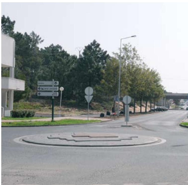
Santo André / Os trabalhos na rotunda das Torres foram da responsabilidade da autarquia e interceptaram a Av. de Santiago com a Rua das Dunas
