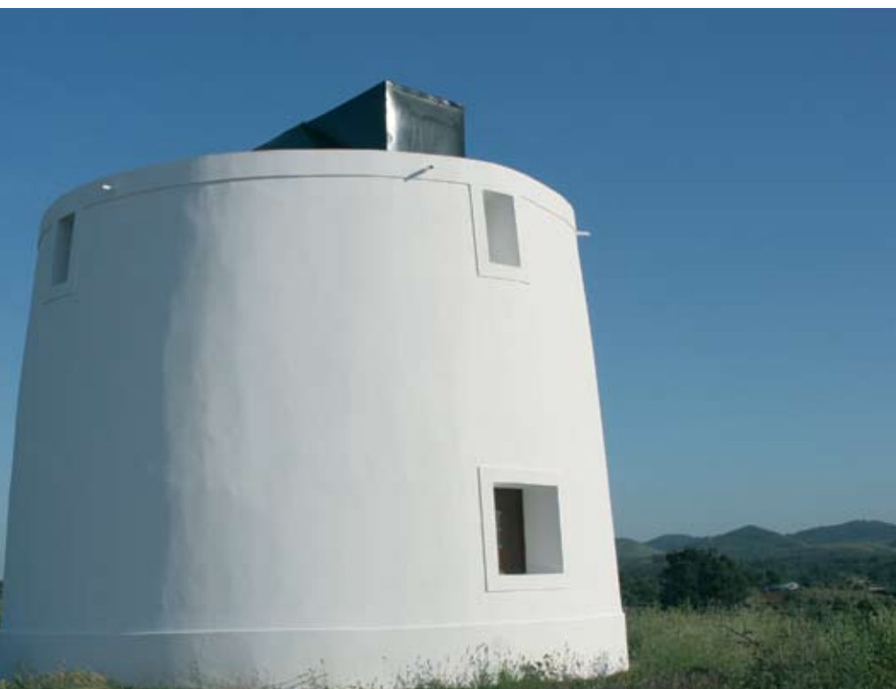
Cercal / O Moinho das Teimosas foi recuperado pela autarquia. Os trabalhos incluíram o reforço da estrutura, revestimento das paredes, canalização para infra-estruturas eléctricas, cobertura, entre outros
