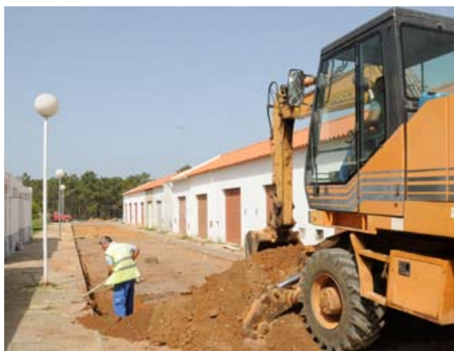
Santo André / A pavimentação do acesso às garagens do Bairro Pôr-do-Sol era um desejo antigo dos moradores e custou 70.000 euros
