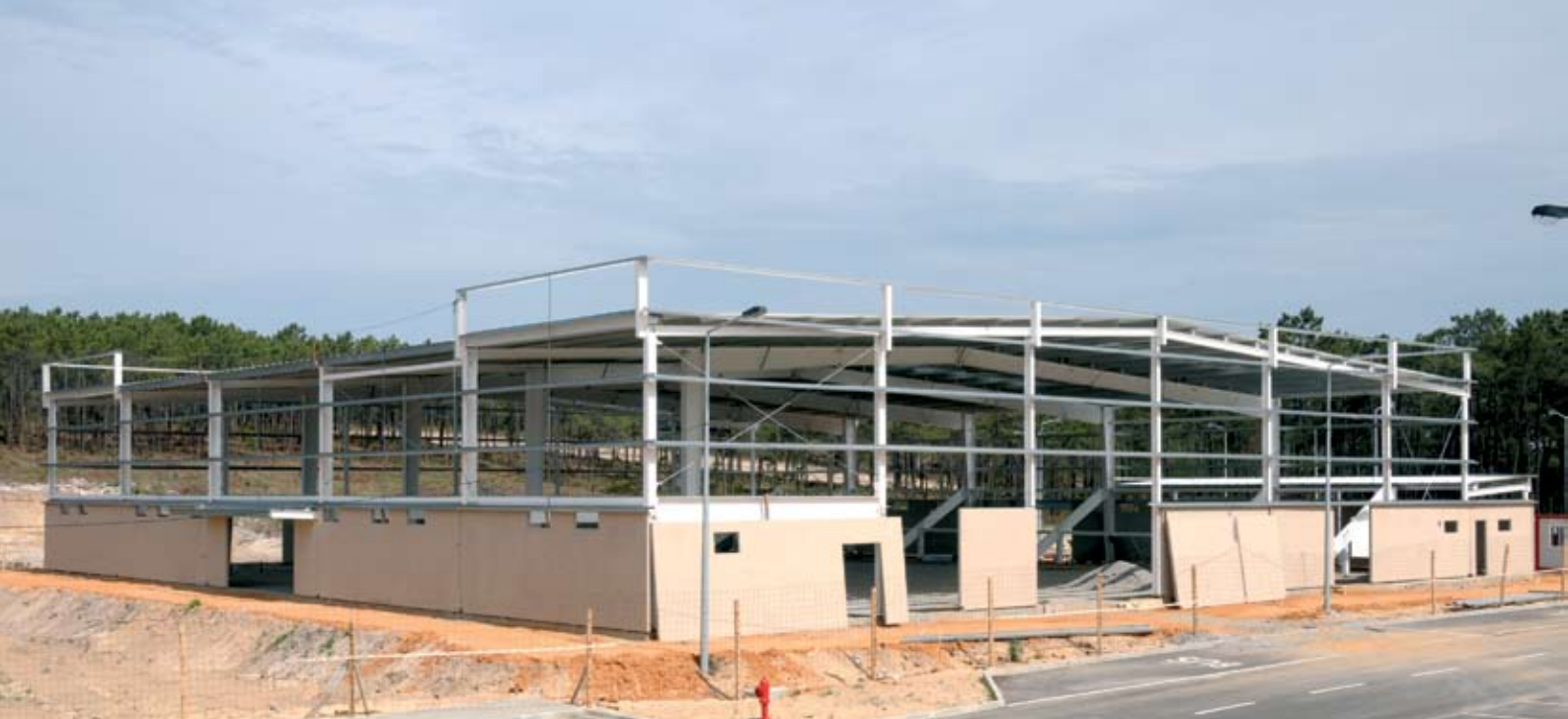
O novo Pavilhão de Desportos está em construção, em Vila Nova de Santo André e será gerido pelo Estrela de Santo André. Este novo equipamento está a ser construído pelo LIDL como contrapartida pela cedência, por parte da Câmara Municipal, do espaço para a instalação da loja do grupo
