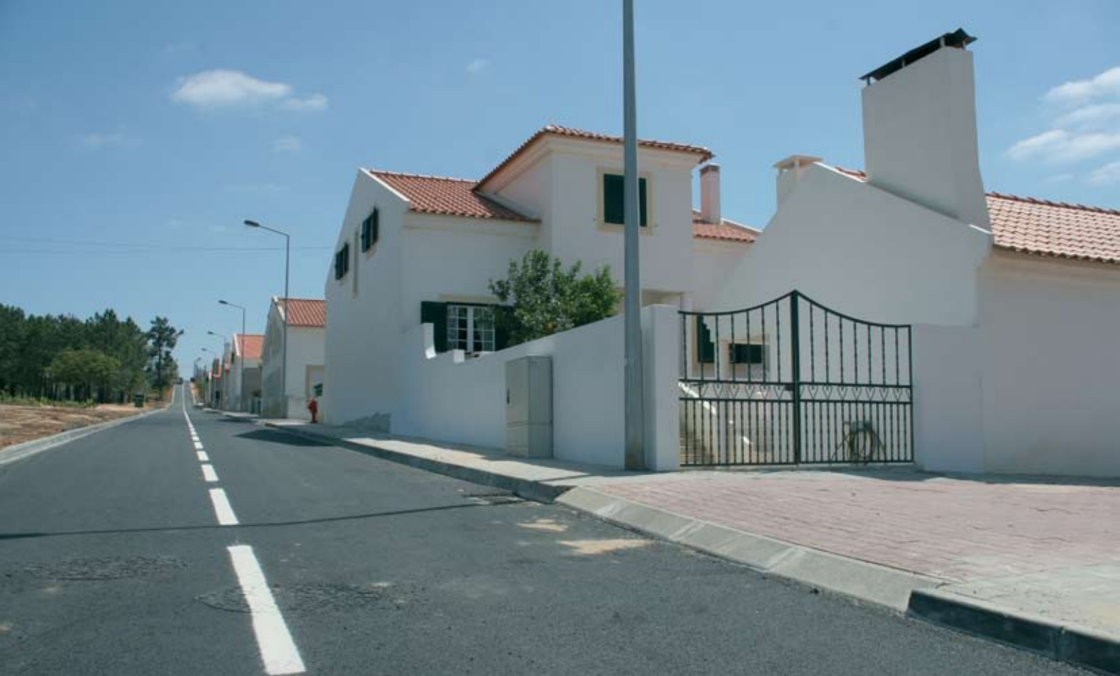
Santa Cruz / A população vê o Loteamento Municipal de Ademas com novas infra-estruturas: instalação da rede de águas pluviais e residuais domésticas, instalação de rede de electricidade enterrada, reperfilamento e pavimentação dos arruamentos e execução de uma estação de tratamento de águas residuais no valor de 416.920,10 euros
