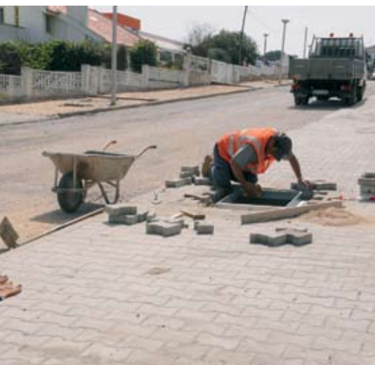
Santo André / Devido às raízes das árvores foi recolocado todo o passeio no Bairro Horizonte
