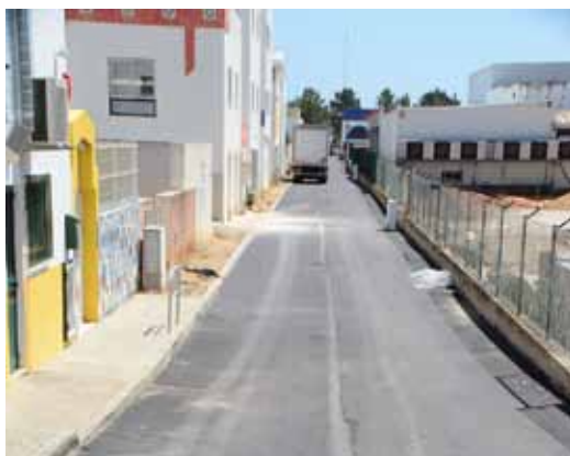
Rede de drenagem de águas pluviais no arruamento a tardoz da Zona de Atividades Mistas (ZAM).
