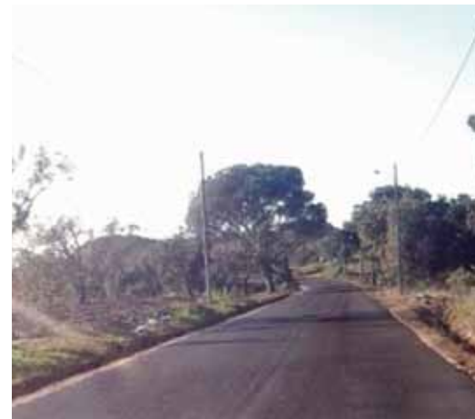
Intervenção na EM 544 com saneamento de raízes e argilas, devido às irregularidades no pavimento.
