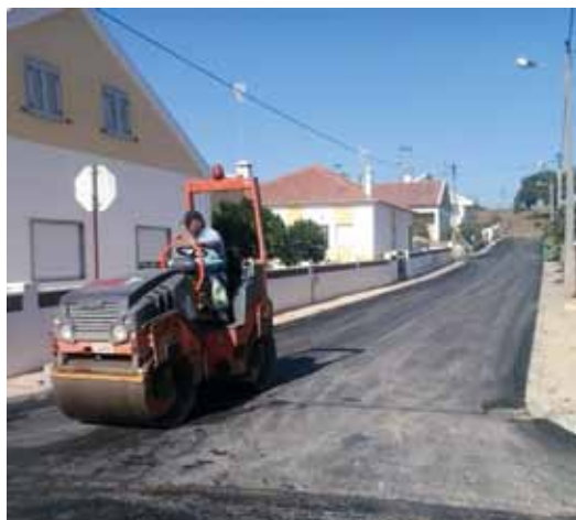
Execução da rede de águas pluviais no Outeiro do Lobo.
