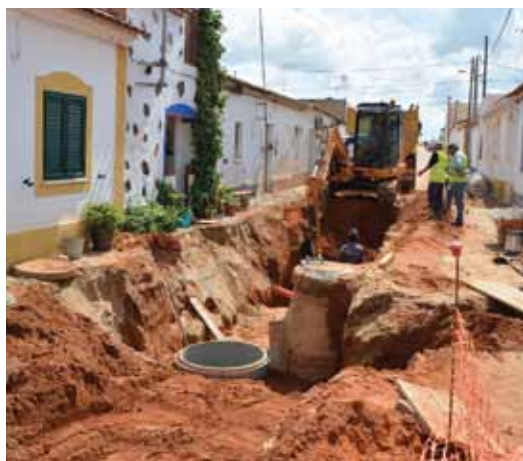
Execução da rede de drenagem de águas pluviais da Rua Catarina Eufémia.
