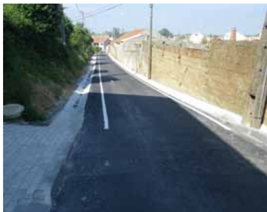
Reabilitação de um troço da Rua Álvaro Cunhal. Trata-se de um investimento de 43.383,87 €.
