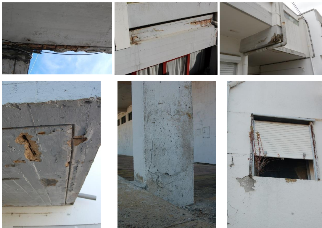
Foto 4 – Bairro da Atalaia e Bairro Pôr do Sol – Exemplos de degradação da estrutura
