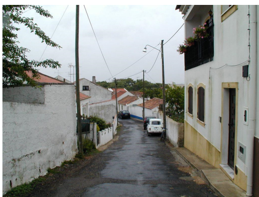
Iluminação pública aérea e luminárias desadequadas
