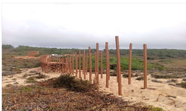
Figura 14 e 15 – Fotografias durante a obra de alteamento do passadiço
