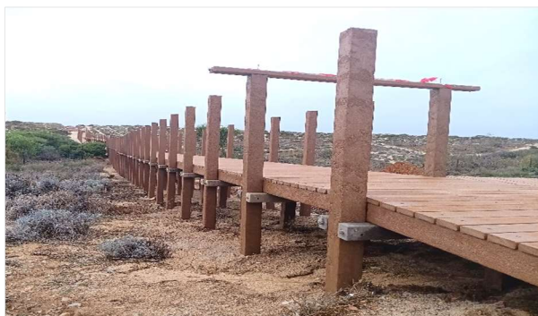
Figura 12 e 13 – Fotografias durante a obra de alteamento do passadiço
