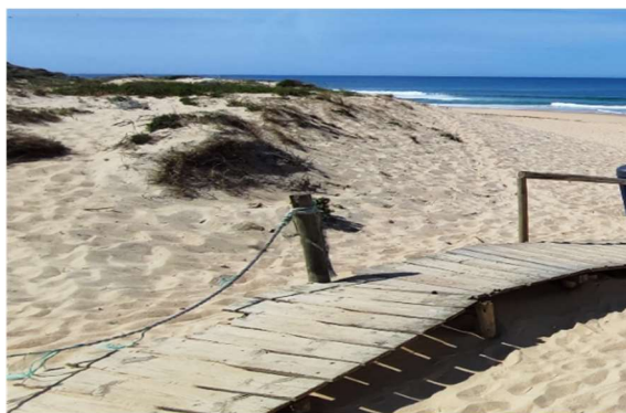
Figura 6 - Pormenor da degradação do passadiço na praia do Monte Velho
