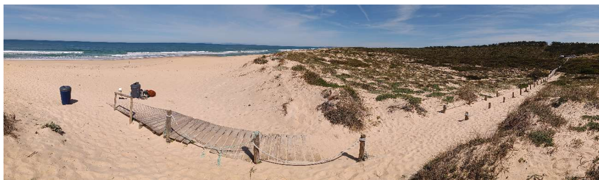
Figura 8 – Parte do passadiço da Praia do Monte Velho soterrado
