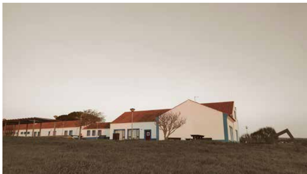
Figura 16 - Vista exterior do Centro Nacional de Educação Ambiental e Conservação da Natureza, no Monte do Paio [Fotografia]. João Carlos Farinha, S.d.
