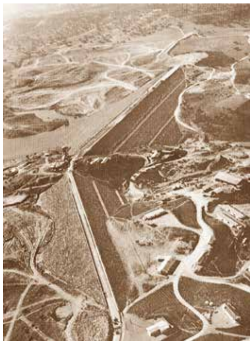
Figura 8 – Vista aérea da Barragem do Monte da Rocha [Fotografia]. Panoias, 1970.
